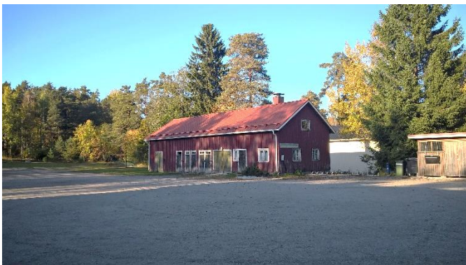
Kuva. Koulun piharakennus toimii varastona. Katto on uusittu kesällä 2017.
